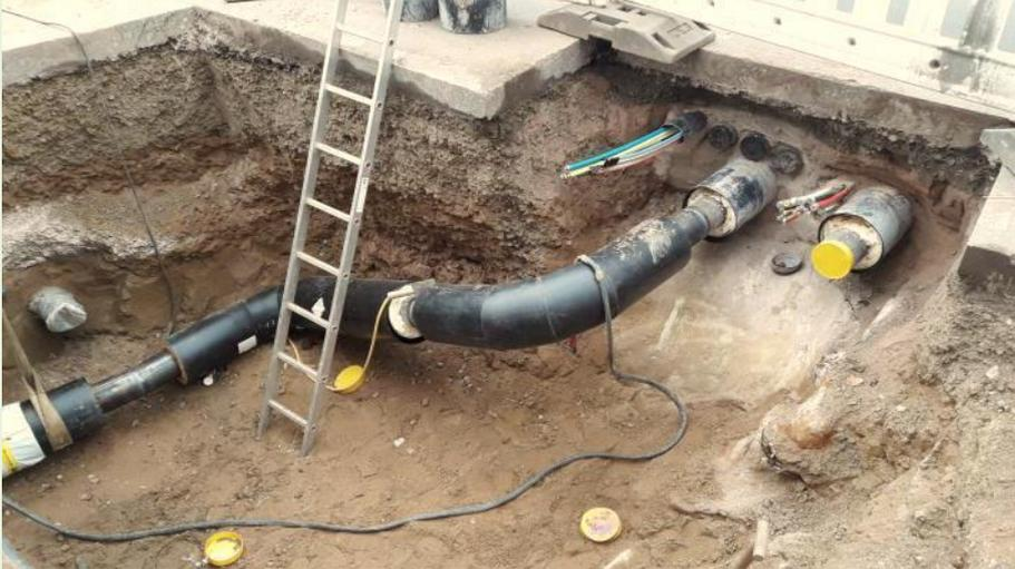
Im Bild sind neben den zwei gedämmten Fernwärme-Rohren auch die farbigen Leerrohre für die Glasfaserleitung zu sehen.
