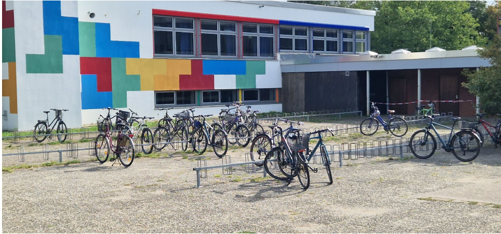
Abb. 3.17 Unzureichende Radabstellanlage am Schulzentrum Süd – „Felgenkiller“ und fehlende Überdachung
