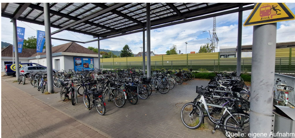
Abb. 3.14 Ausgelastete B+R-Anlage am S-Bahnhaltepunkt Springe
