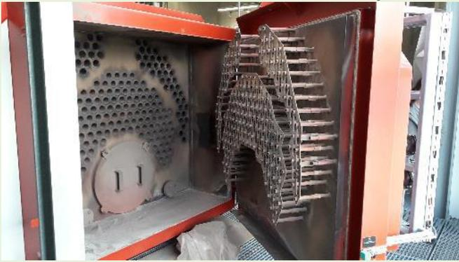
Nachdem der Kessel den ersten Winter alle angeschlossenen Liegenschaften in Springe gut mit Wärme versorgt hat, erhält er derzeit die erste Inspektion. Die Rückmeldung aus dem Innenleben (auf dem Foto die Heizregister des Wärmetauschers – in den Rohren strömen die Rauchgase) deutet auf einen tadellosen Betrieb hin.
